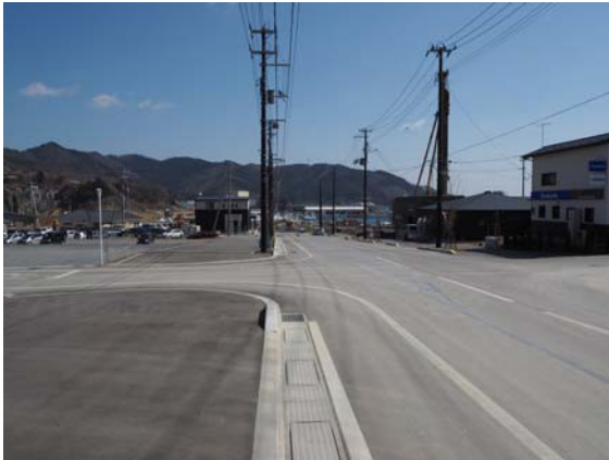
写真3 駅付近の道路 工事中の箇所も多い
