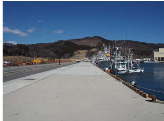
写真19 修復された岸壁
