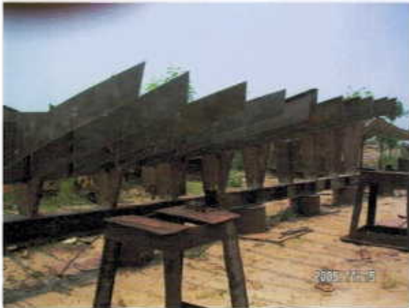
写真. 3 建造中のV字底船舶
