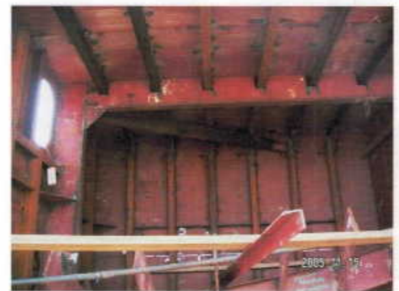
写真. 6 建造中のタグボートの内部構造
