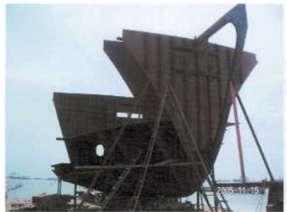
写真. 5 建造中のタグボート（船首側）
