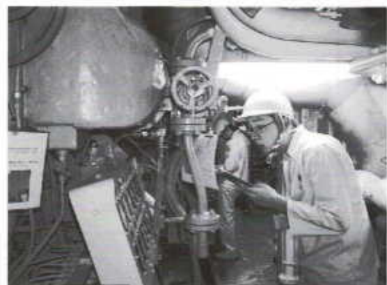
図4 運転状態の確認
