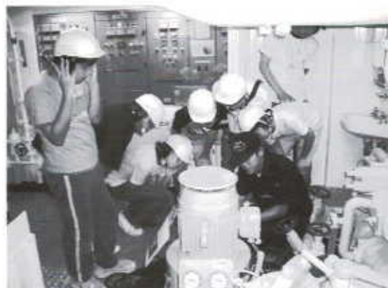
図6 機関室での調査
