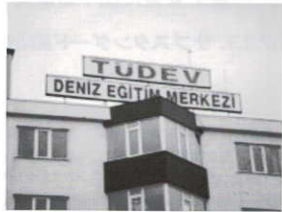
写真2 トルコ海事訓練センター屋上
